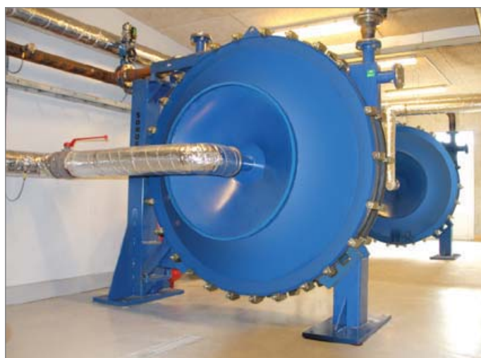
Intercambiador de calor espiral Sondex a Linko Gas, Dinamarca.
